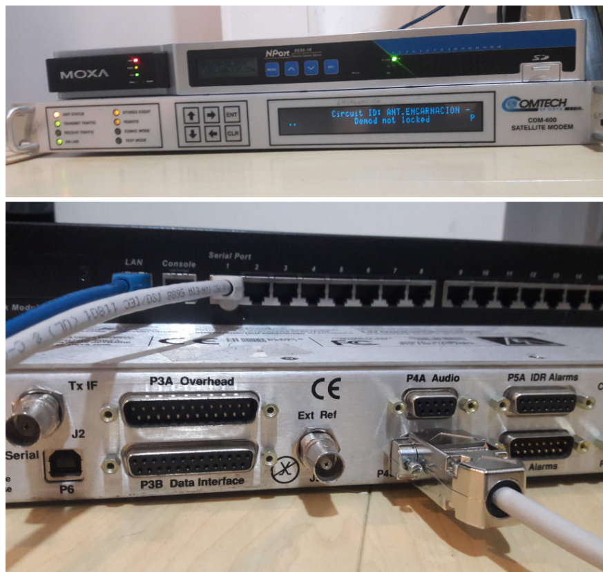
Figura 6-7.: Montaje de equipos heredados Fuente propia
